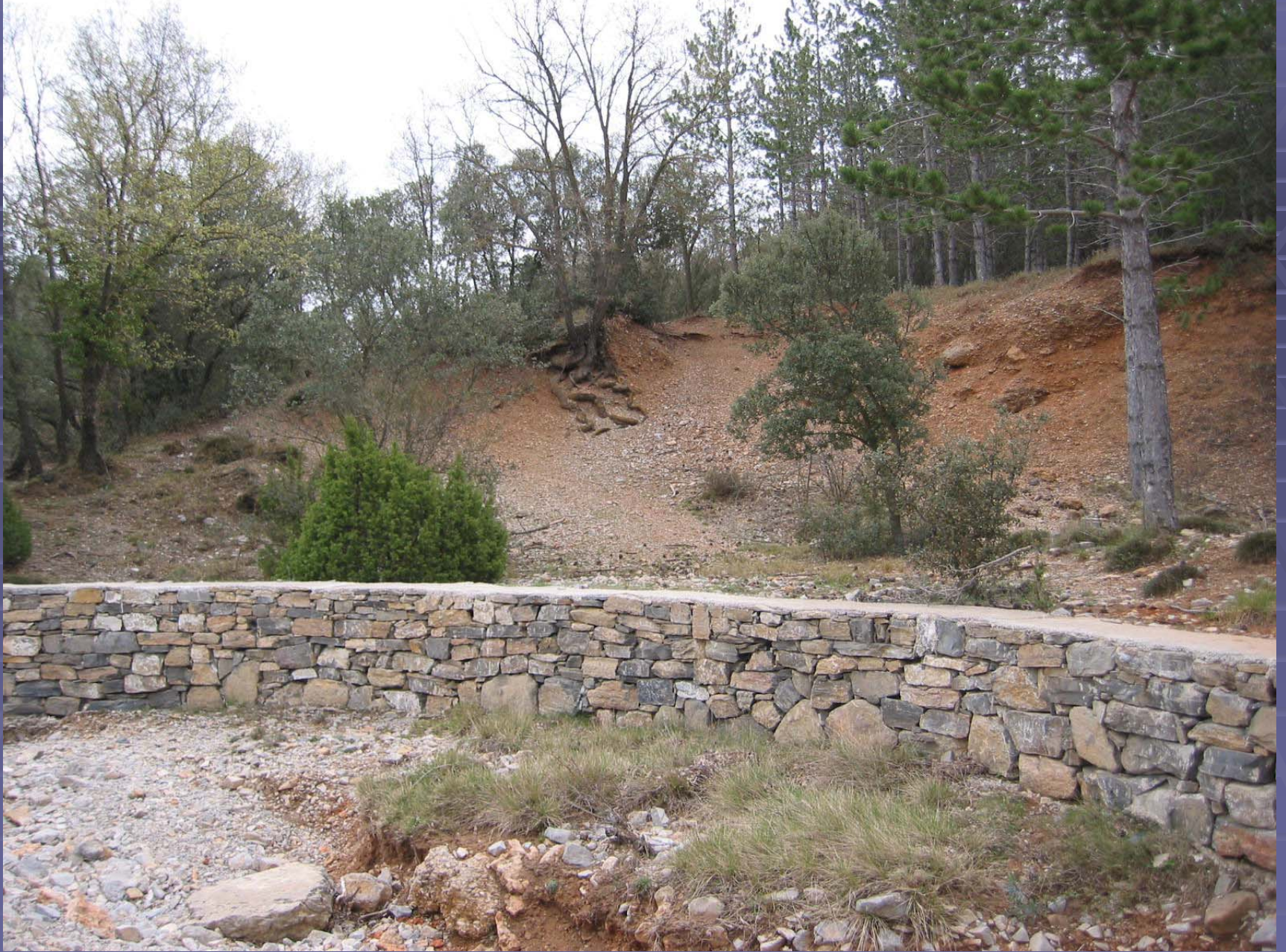
Muretes de mampostería contra erosión
